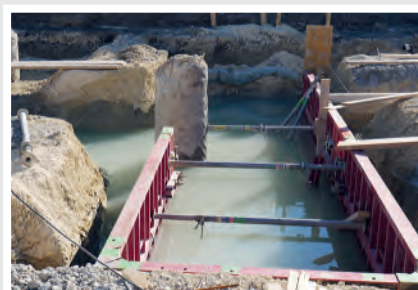
Neubau Sporthalle Schillerschule Erbach
