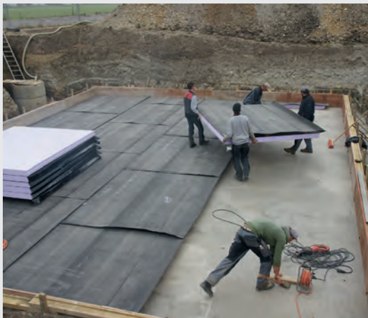
Auslegen der Bodenplattenelemente
