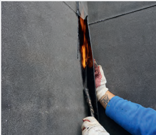
Verschweißen der Fugen
