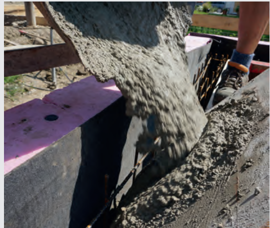
Betonieren der Wände
