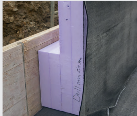
Auslegen der SRE - Elemente
