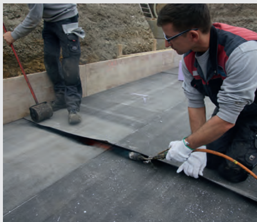
Verschweißen der Fugen
