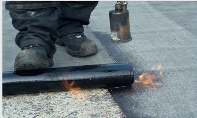
Bild 5: Längsstoß mit 8 cm Überlappung
