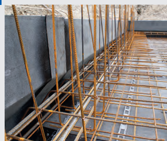
Auslegen der Bewehrung
