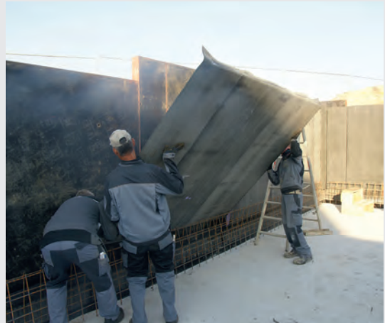
Einlegen der Wände in die Schalung
