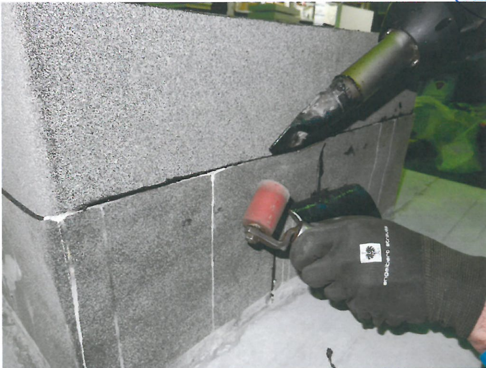
Bild 12: Verschweißen der Frischbetonverbundbahnen
