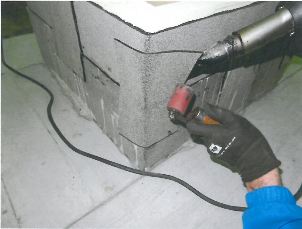
Bild 15: Sicherung der Ecken
