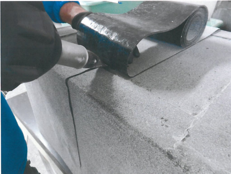
Bild 6: Verschweißen des Frischbetonverbundbahn-Streifens am Elementstoß
