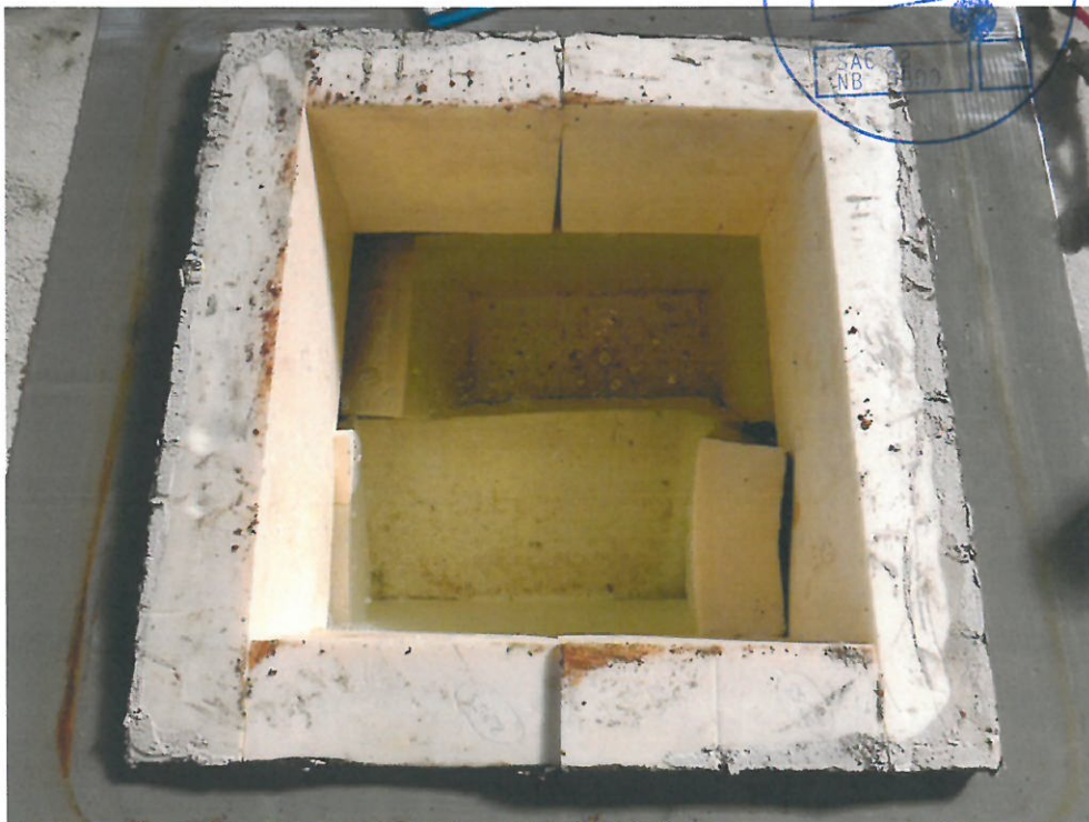
Bild 18: Verschiebung der Dämmplatten infolge der Druckwasserbeanspruchung
