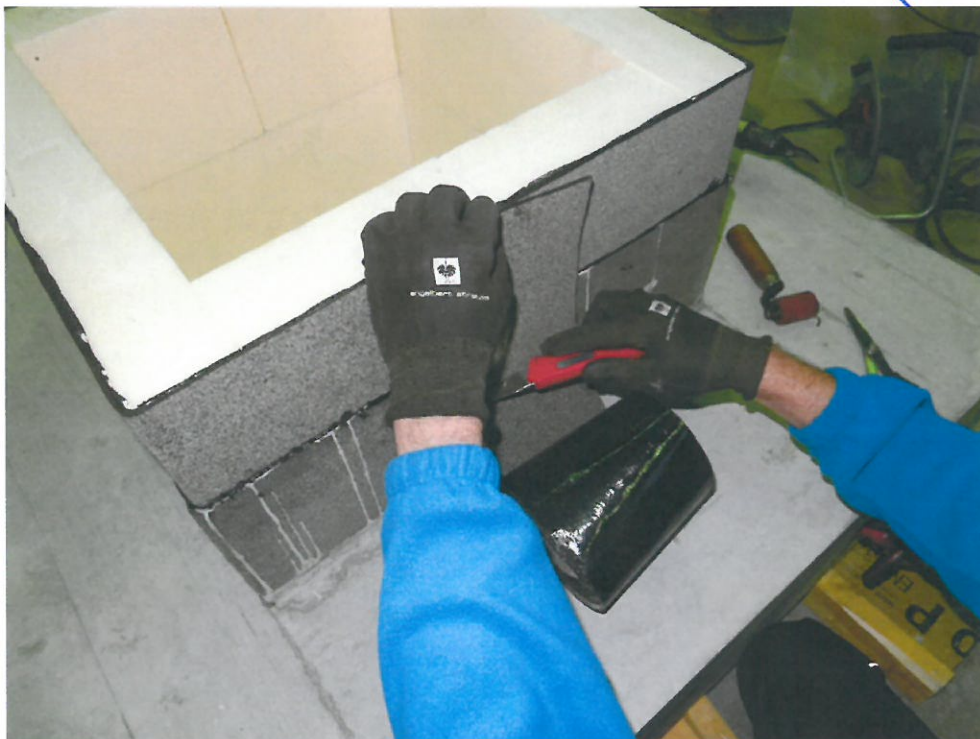
Bild 14: Sicherung des Stoßes der oberen Elemente
