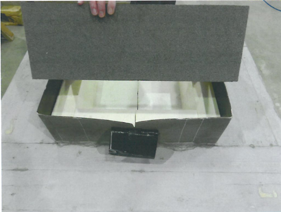
Bild 10: Einsetzen des 1. Elementes für die Rahmenschalung
